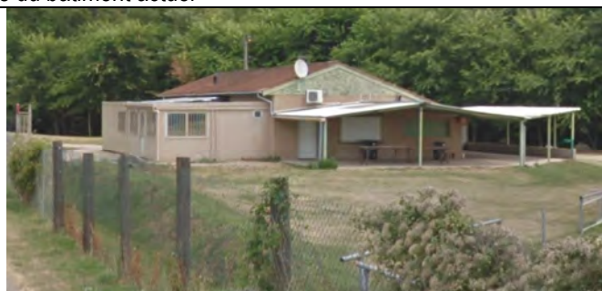
vue depuis le sud-ouest
